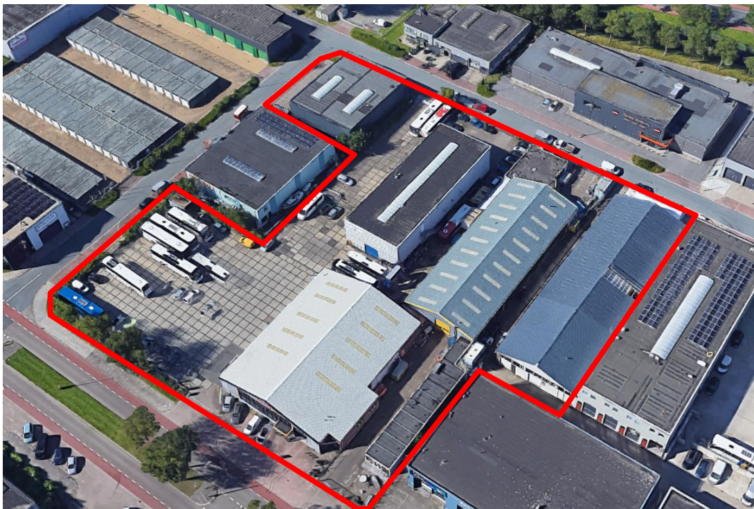
Afbeelding 2.1: Huidige situatie projectlocatie
