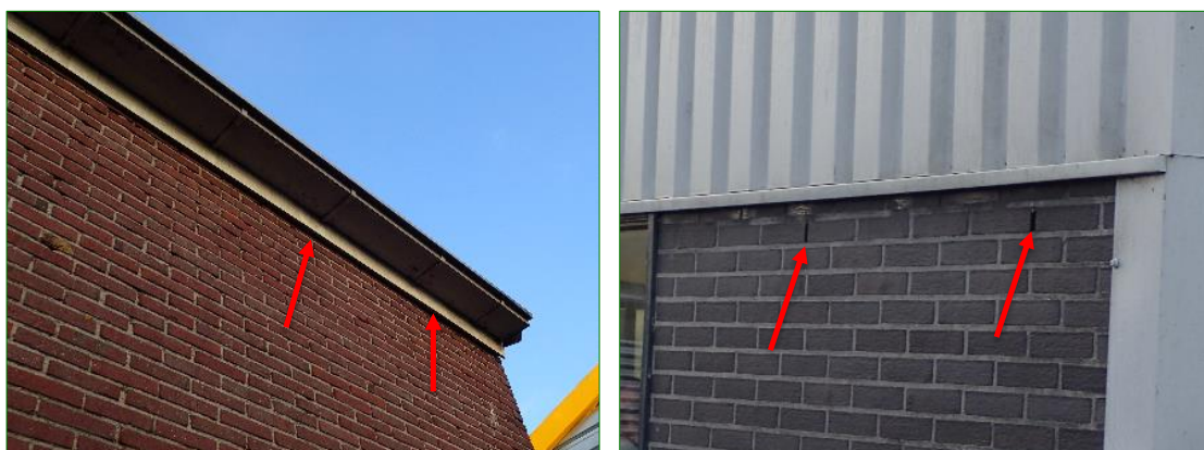
De openingen in de spouwmuur en onder dakranden (rode pijlen) van de bebouwing geven mogelijk toegang tot voor vleermuizen geschikte achterliggende ruimtes.
