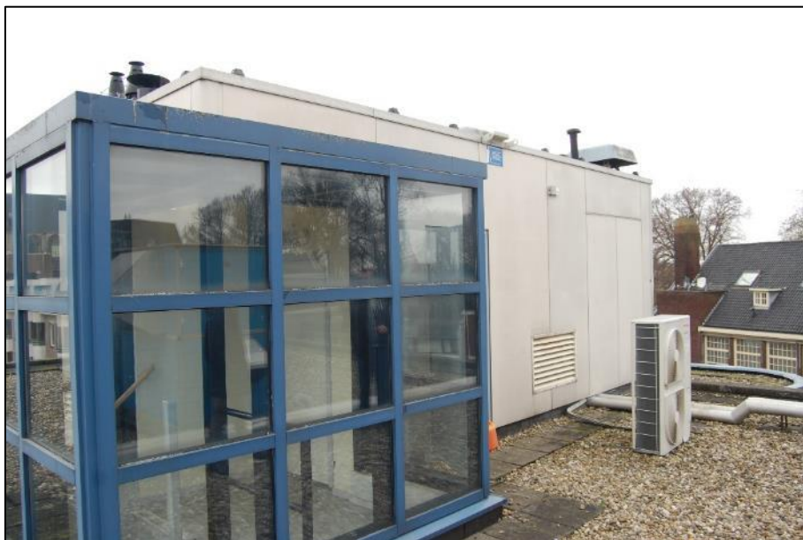
Vierkante opbouwen op het dak.
