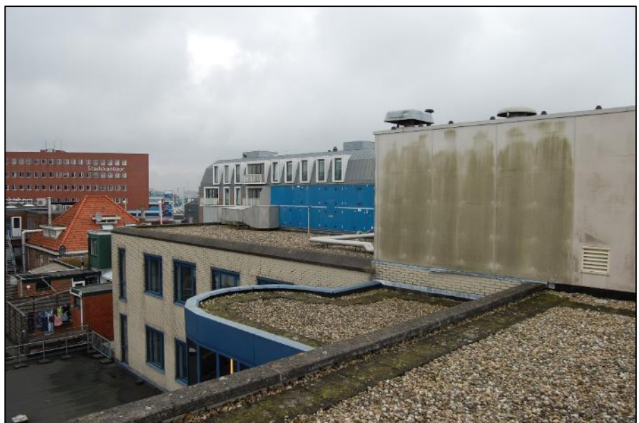
Rechts plat dak met grind, links plat dak met bitumen.
