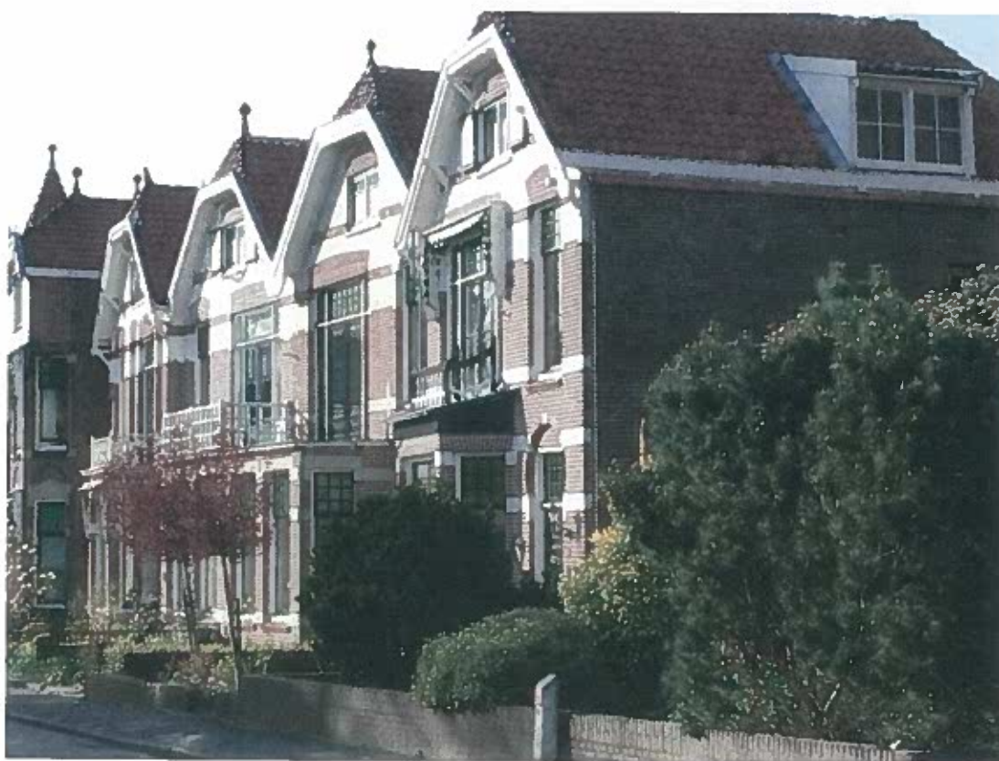
Bestaande woningen Van Everdingenstraat
