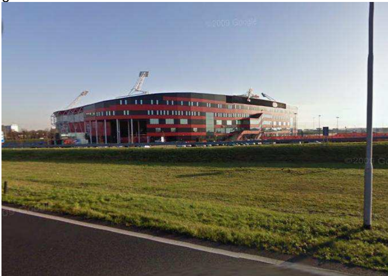
Figuur 3. Aanzicht AZ Stadion vanuit het zuidwesten
