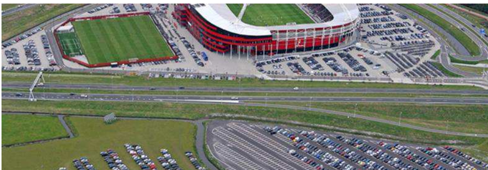
Figuur 7. Luchtfoto parkeerterreinen in gebruik
