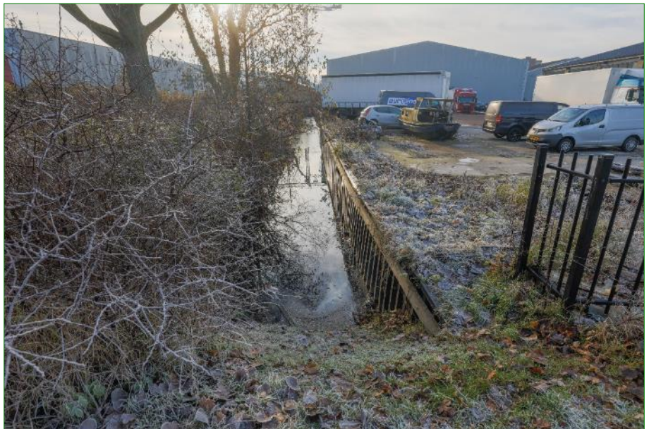
De watergang met steile beschoeide oever en groenstrook in het oosten van het plangebied.
