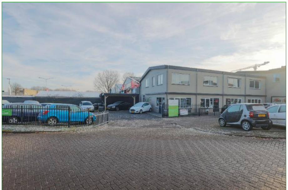
Het plangebied gezien vanuit noordwestelijke richting met op de voorgond de bebouwing van het perceel Kennemer Haeve met daarachter de bebouwing noordwestkant langs de Edisonweg.
