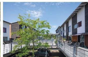
Gaten in het parkeerdek om bomen te planten.
