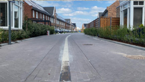
Open watergeleide goot in hart wegprofiel
