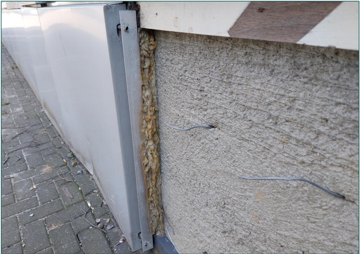
Figuur 3 Achter de metalen cassettes is isolatiemateriaal aanwezig waartussen geen ruimte voor vleermuizen aanwezig is.
