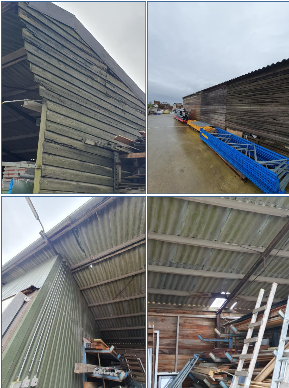
Figuur 6: Boven de houten enkelwandige wanden; onder enkelwandig golfplaten dak
