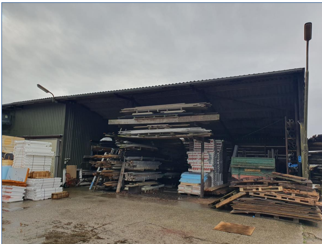
Figuur 2: Foto impressie: de open kapschuur met opgeslagen materiaal
