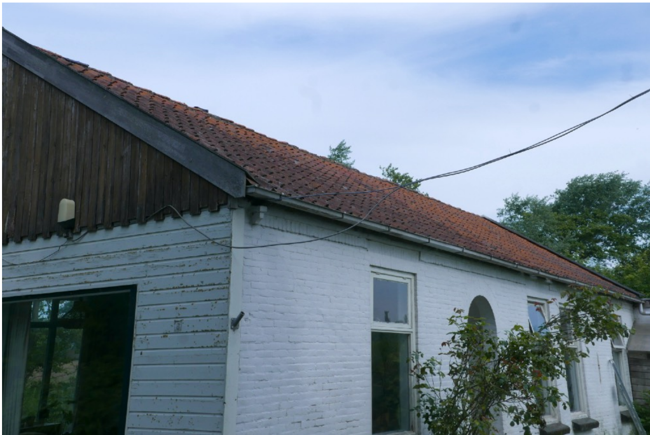
Afb.3: Zicht op een deel van het pannendak en de gevelbekleding. Beide toegankelijk voor vleermuizen.
