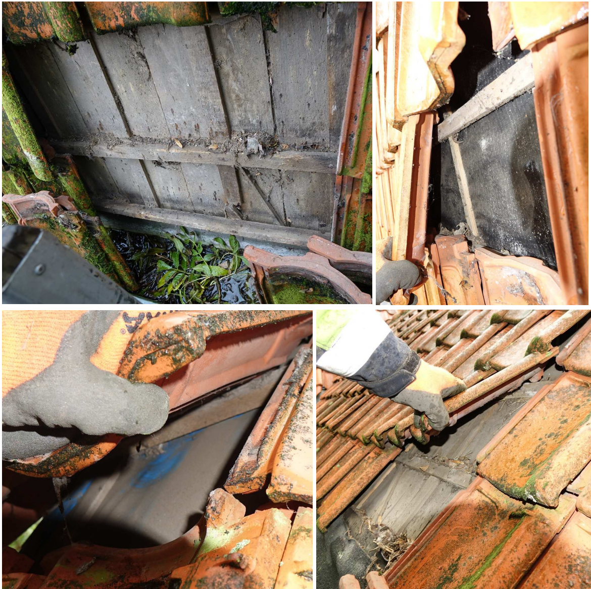
Figuur 3. Bij de dakpaninspectie zijn geen (recente) nesten onder de dakpannen waargenomen
