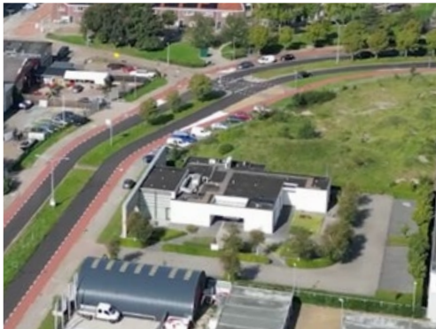
uitvaartcentrum aan de Edisonboulevard
