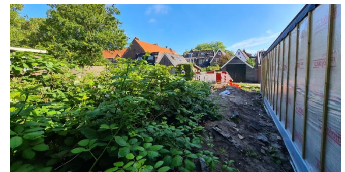
Figuur 9: Plangebied gezien vanaf grens met Koornlaan 13
