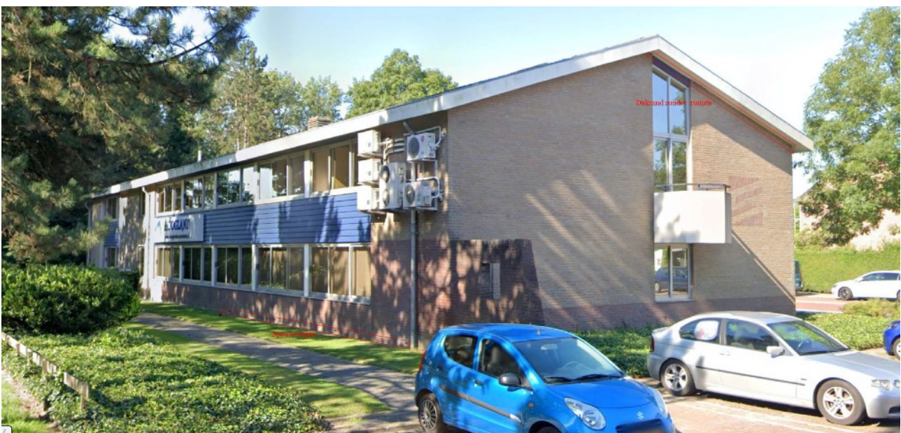
Afb.3: Hellingshoek van het dak te flauw voor gierzwaluwen en bekisting dak te strak tegen de rand en spouwvoegen te laag voor vleermuizen.
