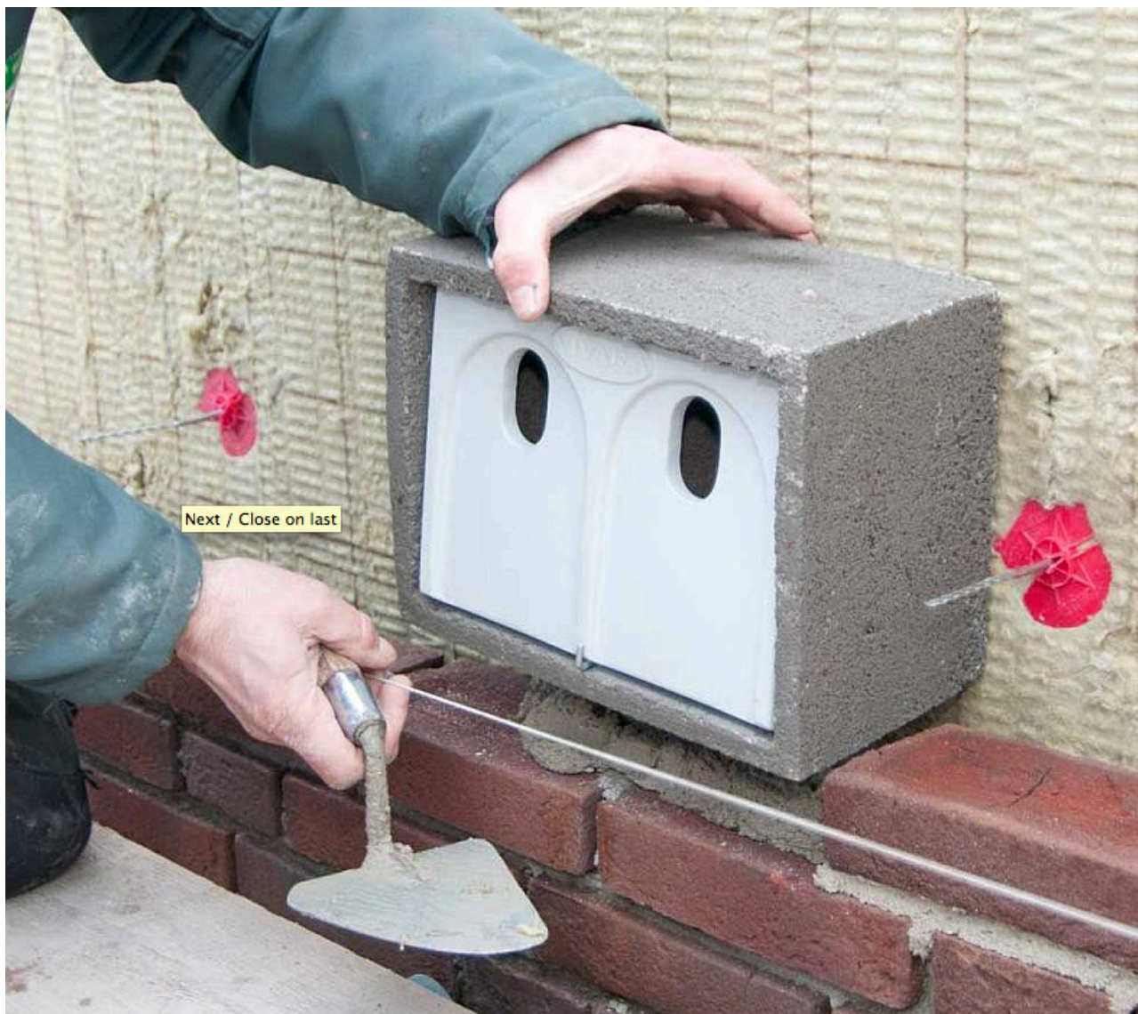
Afb.11: voorbeeld van een nestkast voor huismussen welke kan worden ingebouwd.
