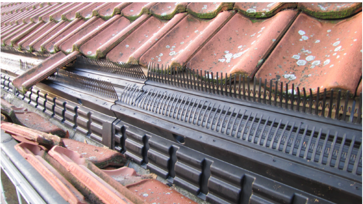
Afb.10: Vogelvides geplaatst onder eerste rij dakpannen.
