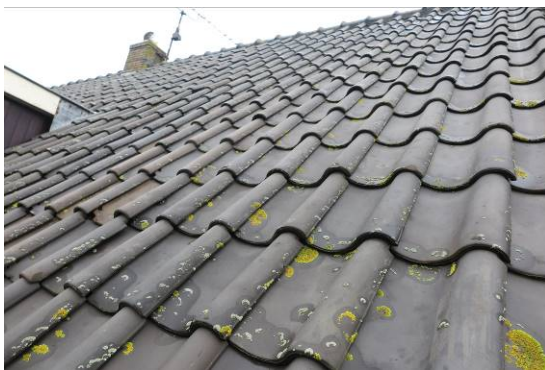
Figuur 5. Volledig dicht dak.
