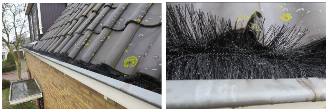
Figuur 6. Vogelwerende maatregelen in de woning aan de Dorpsstraat 39 Oterleek.
