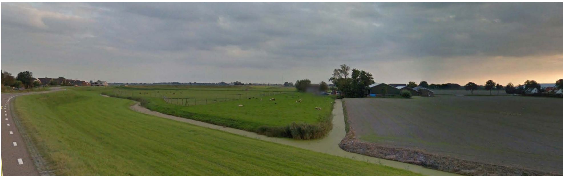
Zicht vanaf de dijk vanuit het noorden op de bestaande sloot en de loodsen op het erf, foto: Google Streetview.
