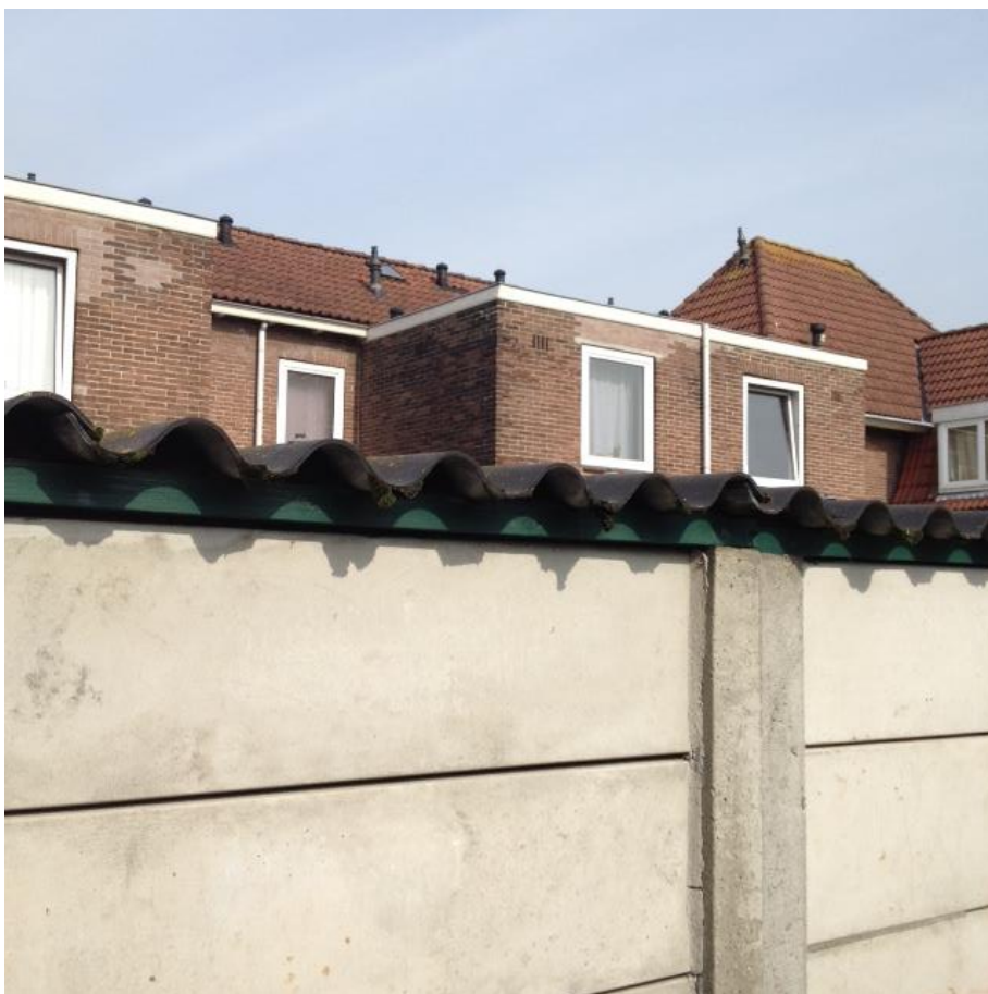
Figuur 5. Uitbouw plat dak achterzijde Hulststraat.
