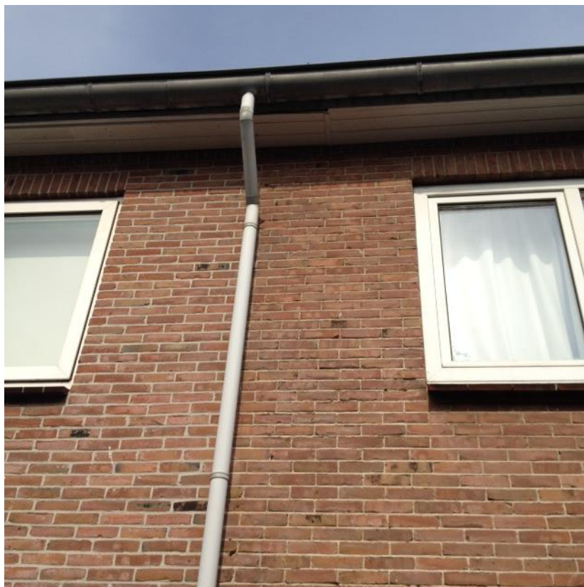
Figuur 6. Losse planken achter goot.
