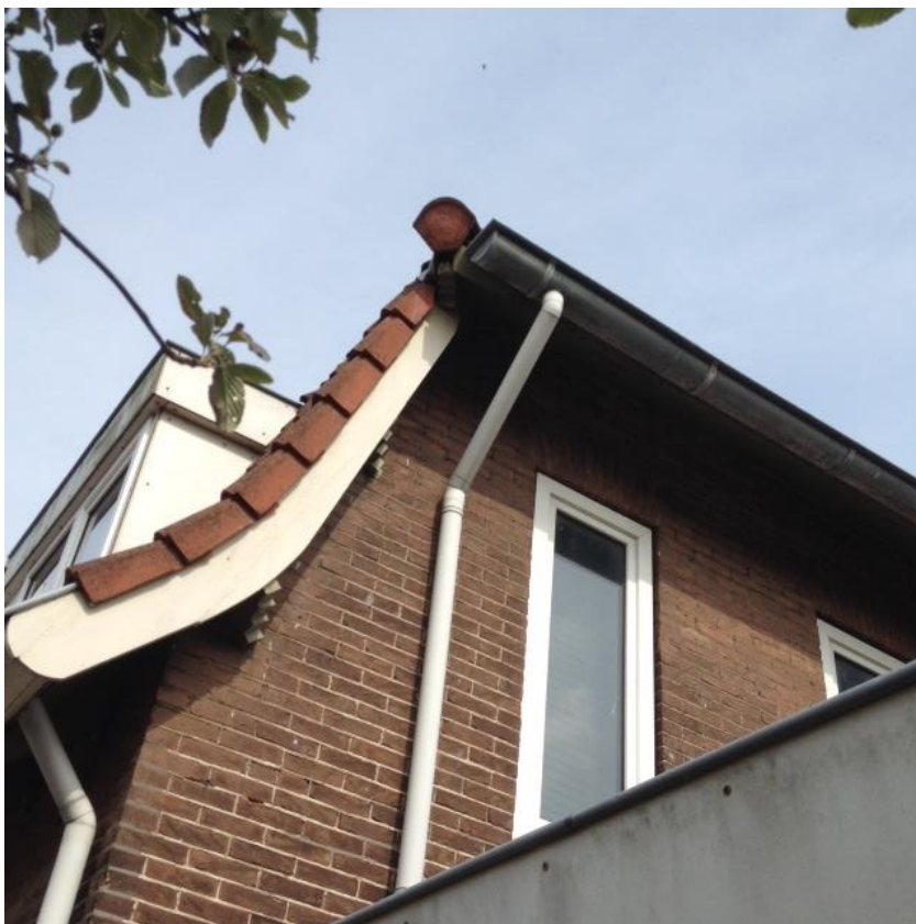
Figuur 8. Hoekkeper Boomkampstraat.
