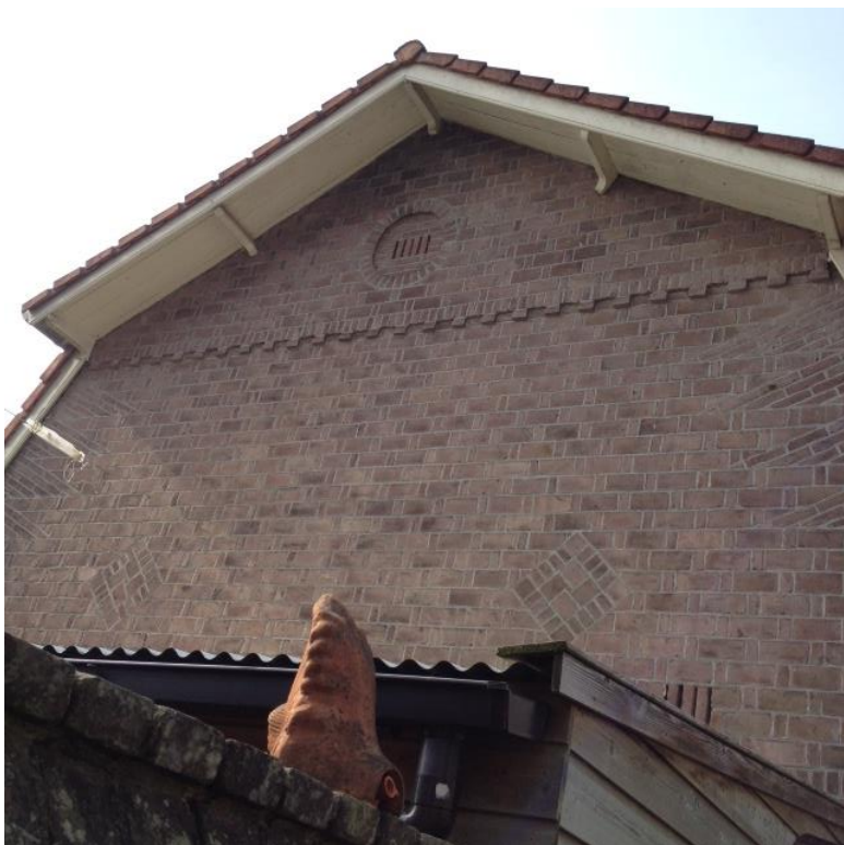
Figuur 4. Spouwventilatie Hulststraat.
