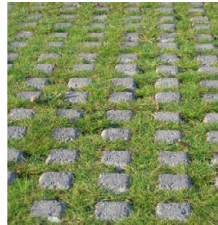
Referentie, parkeren op grasbetonstenen
