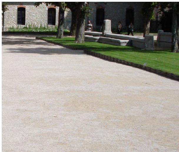
Referentie, oprit van halfverharding
