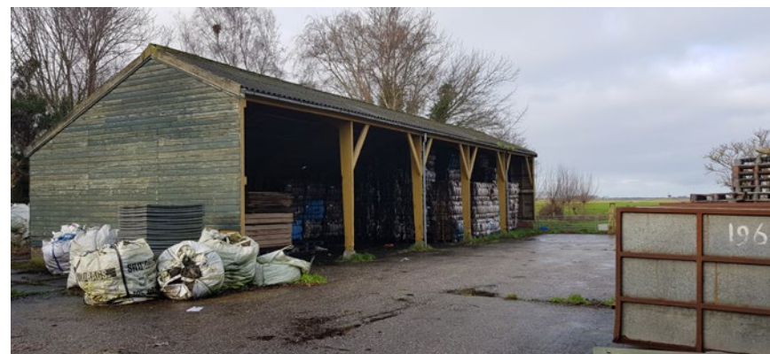
Kapschuur aan westzijde terrein
