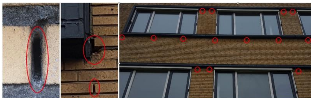
Figuur 2a In het kantoorpand zijn diverse openingen (met name open stootvoegen) aangetroffen in de stenen gevels waardoor vleermuizen mogelijk de achterliggende spouw kunnen bereiken. Dergelijke openingen vormen potentiële vaste rust- en verblijfplaatsen voor gebouwbewonende vleermuissoorten.
