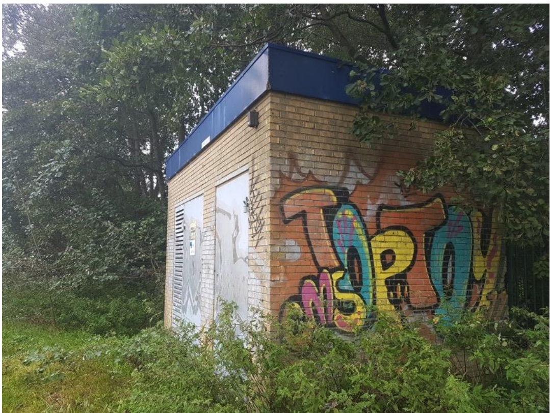
Figuur 4 Transformatorhuis aan de zuidzijde van de planlocatie.
