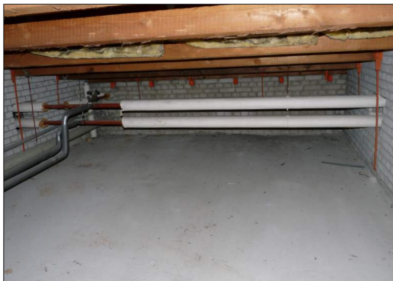
Figuur 8. Zolder van de appartementen
