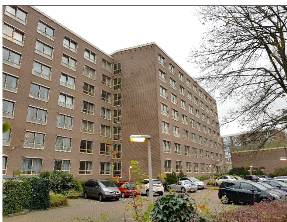
Figuur 5. De twee te slopen appartementsgebouwen van de Albertina Agnesstraat
