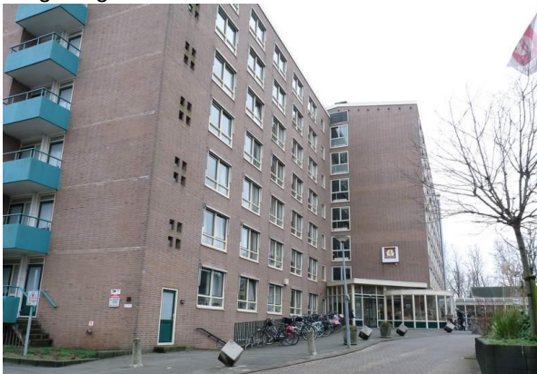
Figuur 3: Overzicht plangebied, de twee te slopen appartementen
