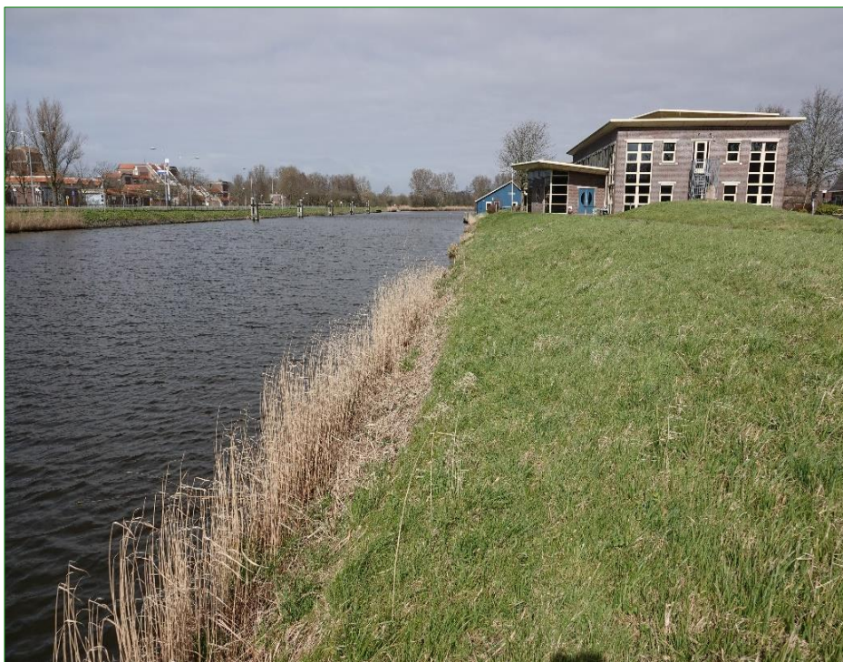
Steile oever met riet langs de waterkant en het kantoorgebouw op de achtergrond.
