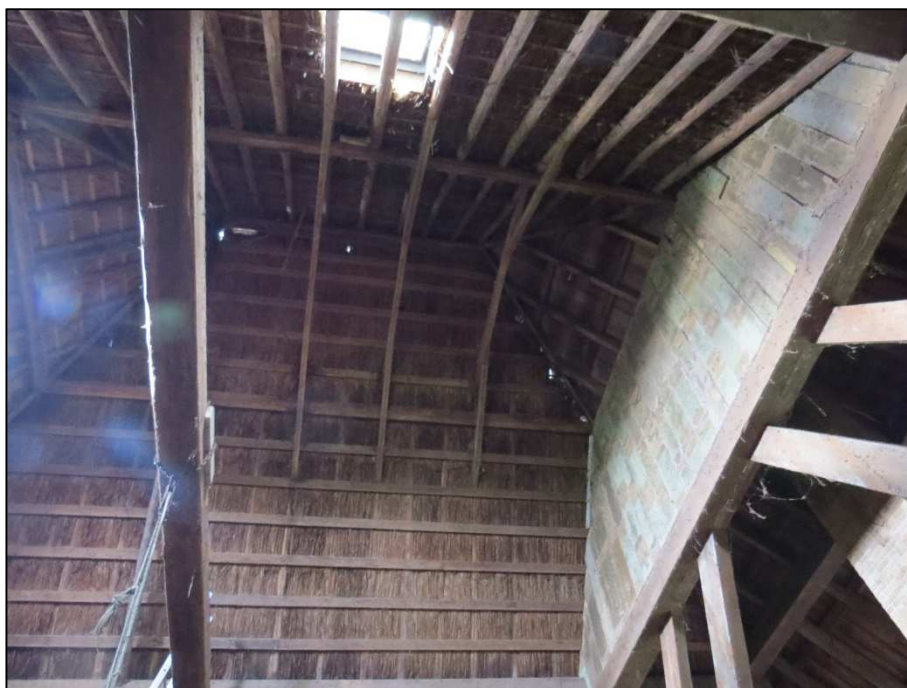
Binnenzijde dak stolpboerderij, zonder dakbeschoot.
