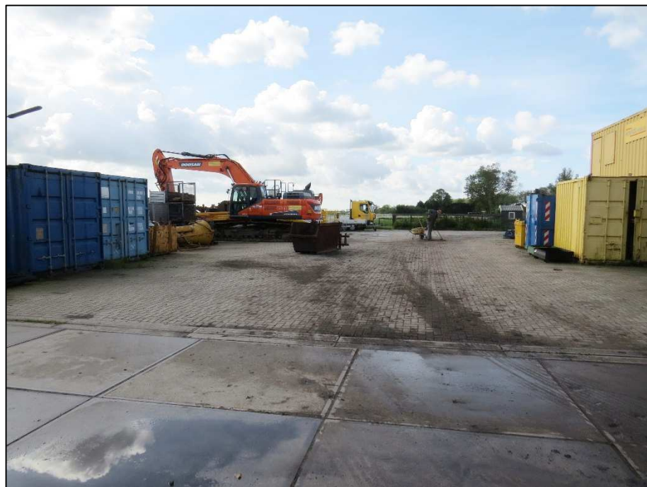
Achterzijde kavel Westdijk 30, met de in 2005 aangebrachte aanvullende acht meter brede strook verharding.
