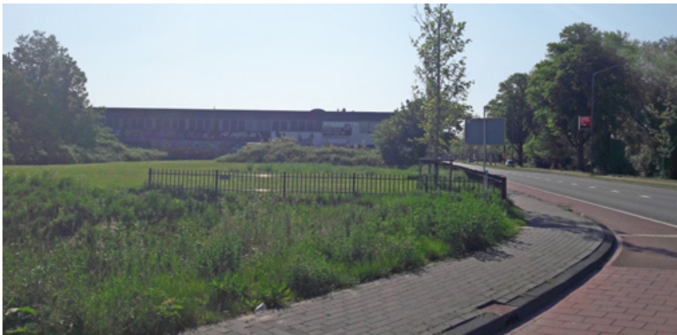
locatie vanaf Oosten
