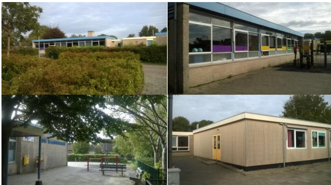
Figuur 1.2e indruk plangebied complex 04 (schoolcomplex 'De Baanbreker')
