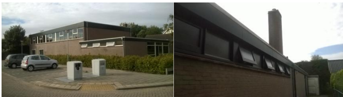
Figuur 1.2f indruk plangebied complex 05 (gymzaal)
