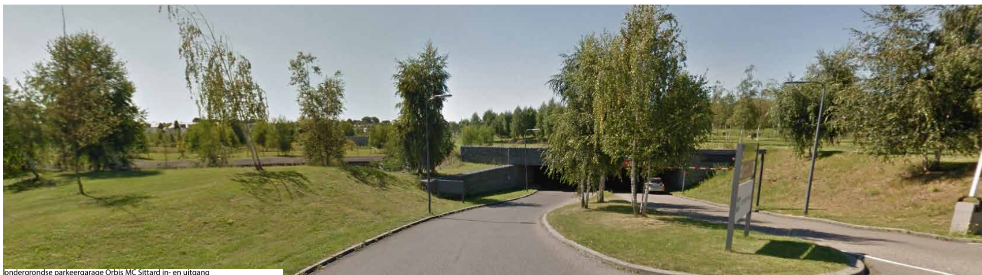
ondergrondse parkeergarage Orbis MC Sittard in- en uitgang
