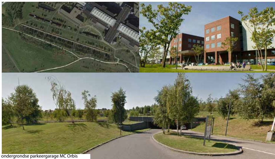
ondergrondse parkeergarage MC Orbis
