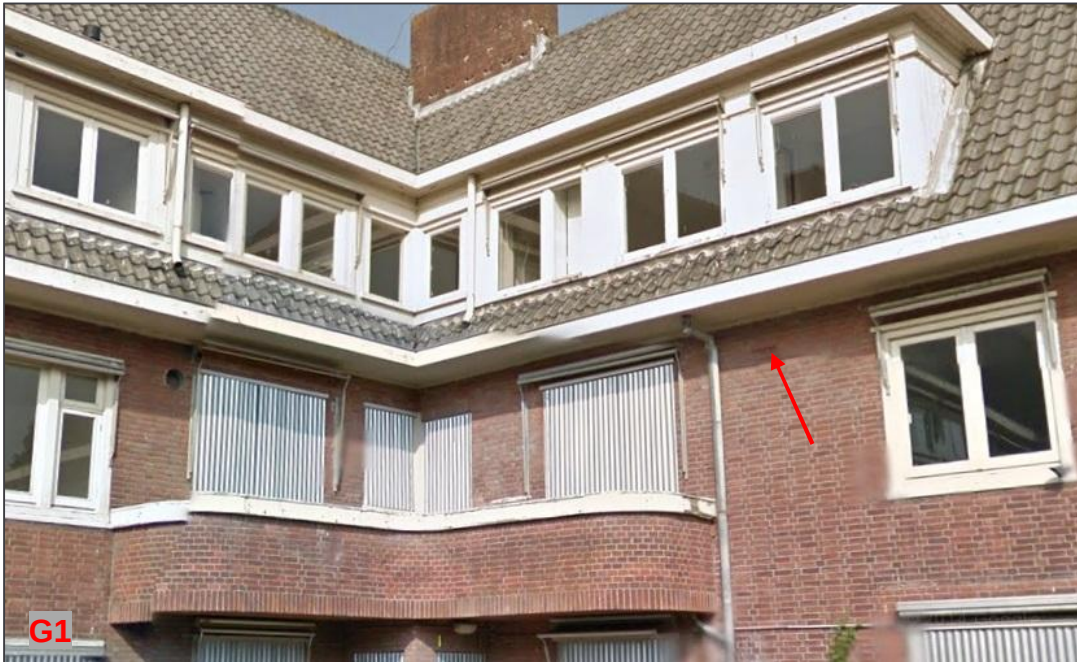
Figuur 3. Gewone dwergvleermuis spouwmuur oostvleugel Westerlicht.
