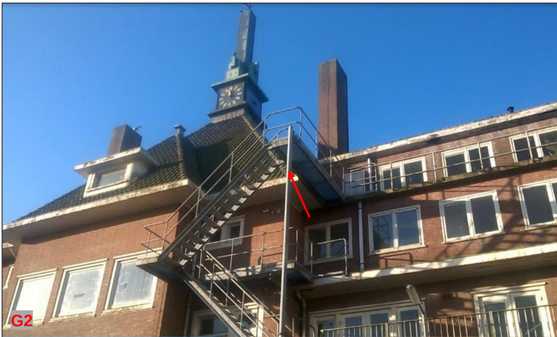
Figuur 4. Gewone dwergvleermuis dakrand torentje Westerlicht (rode pijl betreft invliegopening dakrand).
