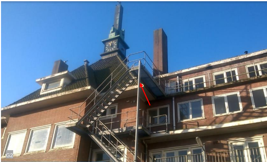
Figuur B1 2 Gewone dwergvleermuis dakrand torentje Westerlicht (rode pijl betreft invliegopening dakrand)
