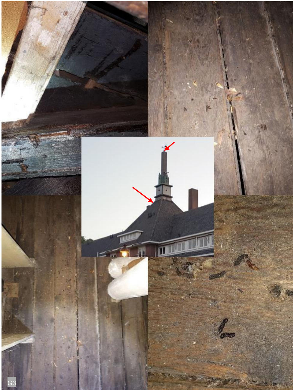
Figuur B1 3 Sporen gewone grootoorvleermuis torentje Westerlicht (rode pijlen betreft invliegopeningen)
