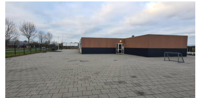
Figuur 6: Noodgebouw gezien vanaf Jacques Perkstraat
