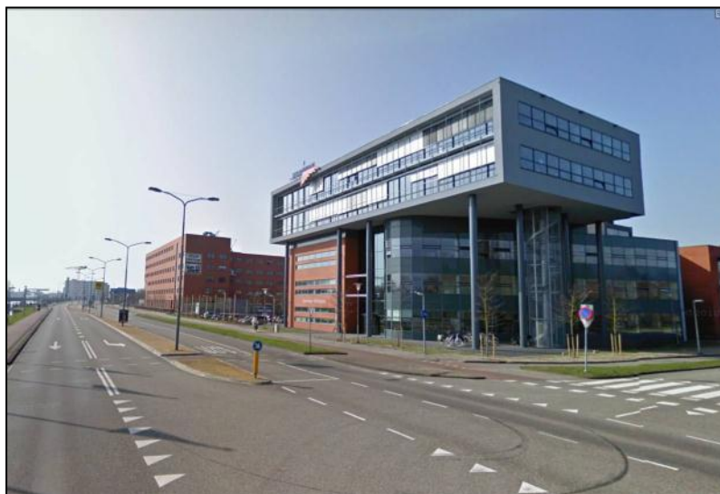
Afbeelding: het gebouw van het Openbaar Ministerie aan de Helderseweg.
