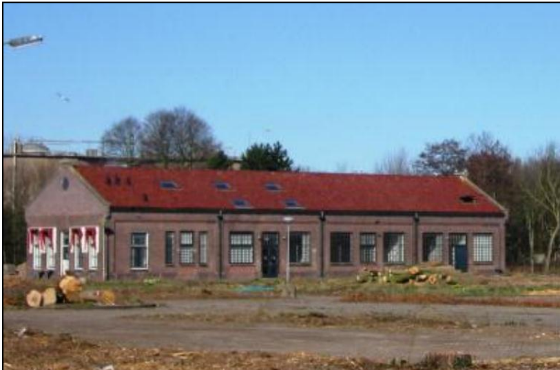
Afbeelding: het gebouw van het voormalig gemeentelijk gasbedrijf
