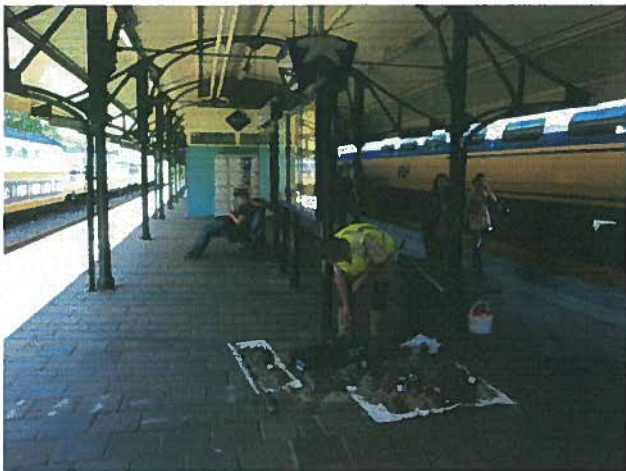
Foto 7: Perron t.p.v. boring 12
