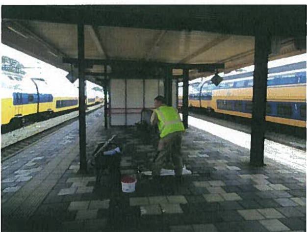
Foto 5: Perron t.p.v. boring 10
