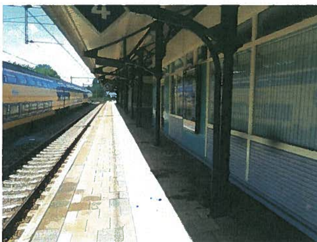
Foto 6: Perrong t.p.v. boring 11
