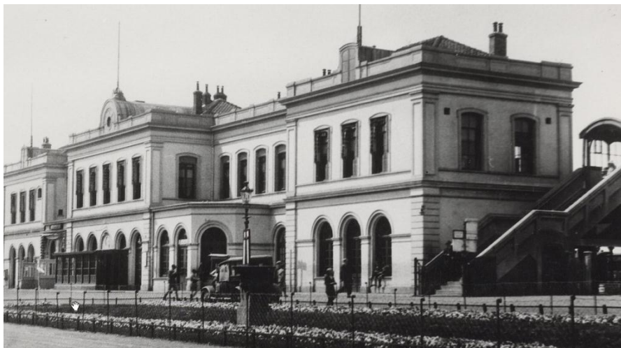
Historisch stationsgebouw. Bron: Beeldbank Alkmaar
