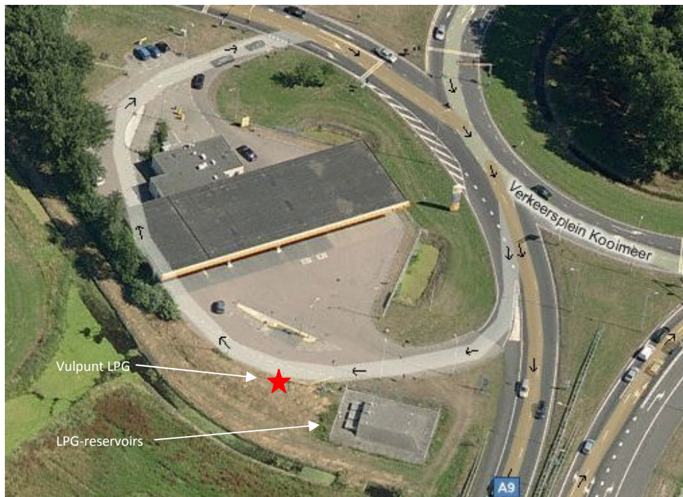
Figuur 4 LPG-tankstation met risicorelevante onderdelen
