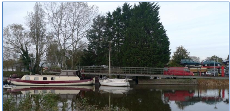
Mogelijk kan de kademuur zichtbaar behouden worden door een brugdeel aan te brengen. (fotobewerking Rob de Vries)
