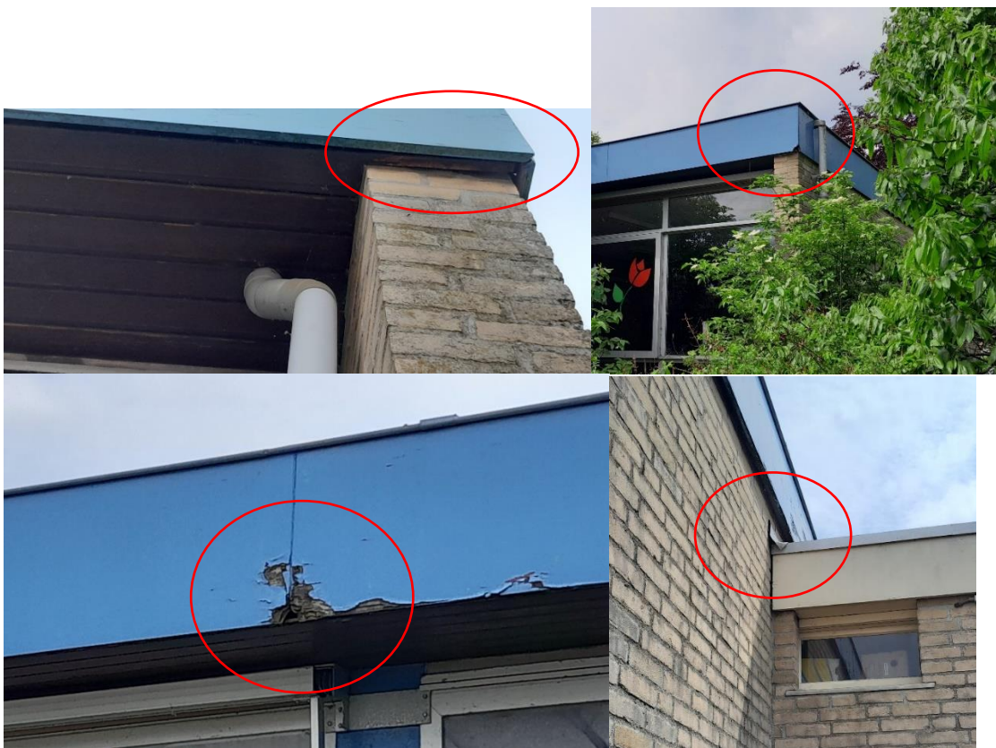
Figuur 2: Voorbeelden van geschikte openingen/gaten voor vleermuizen en gierzwaluwen in de gevels aangetroffen binnen het plangebied.
