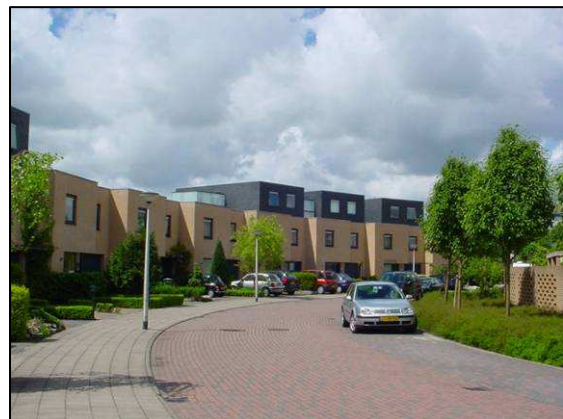
Afbeelding: woning met dakopbouw aan Calveslo
