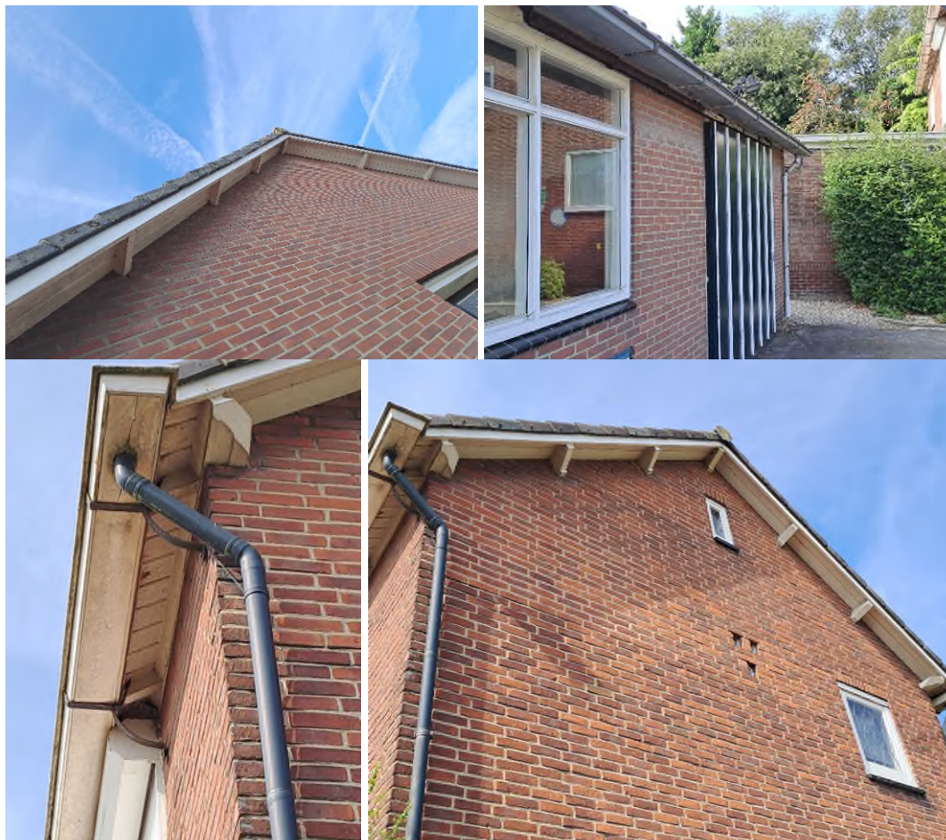
Figuur 3.2 Geschikte openingen voor vleermuizen naar zomer-, paar-, kraam- en winterverblijfplaatsen in en direct naast het plangebied. In de schuur zijn deze aanwezig tussen boeiboorden en muur, tussen kozijn en muur en onder dakranden van de schuur. In de woning zijn deze aanwezig in openingen achter dakgoten, achter dakgoten en tussen boeiboorden en muur van de woning
