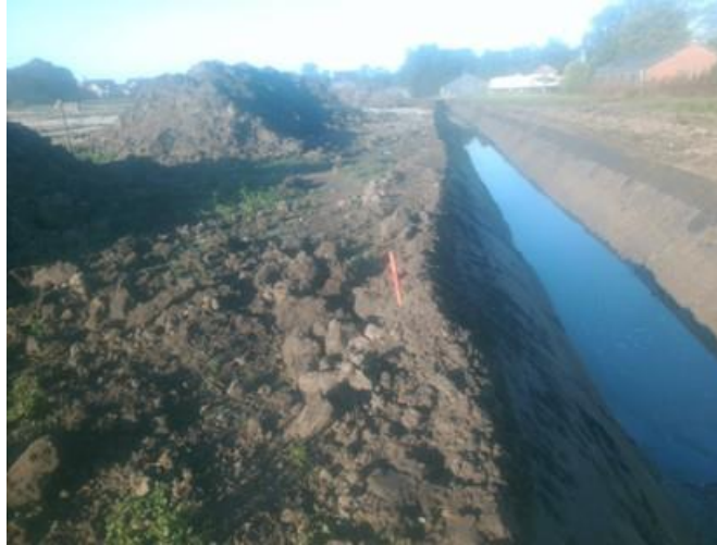
Foto 8: Foto ter plaatse van boring 109
