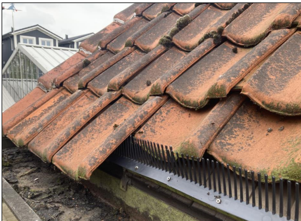
Figuur 4 Het dak van de stenen schuur is (recent) afgedicht met vogelschroot (Bron foto: initiatiefnemer).
