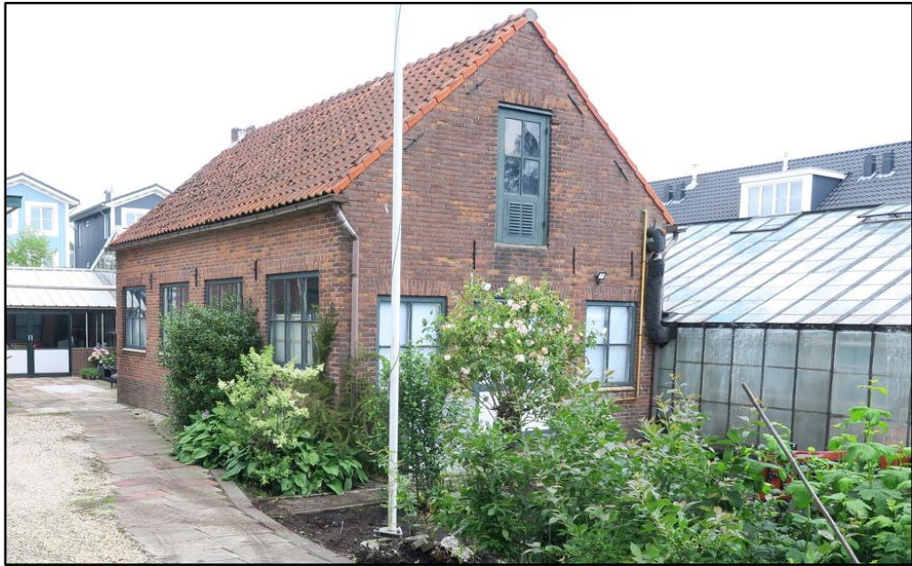
Figuur 3 De stenen schuur op de planlocatie.
