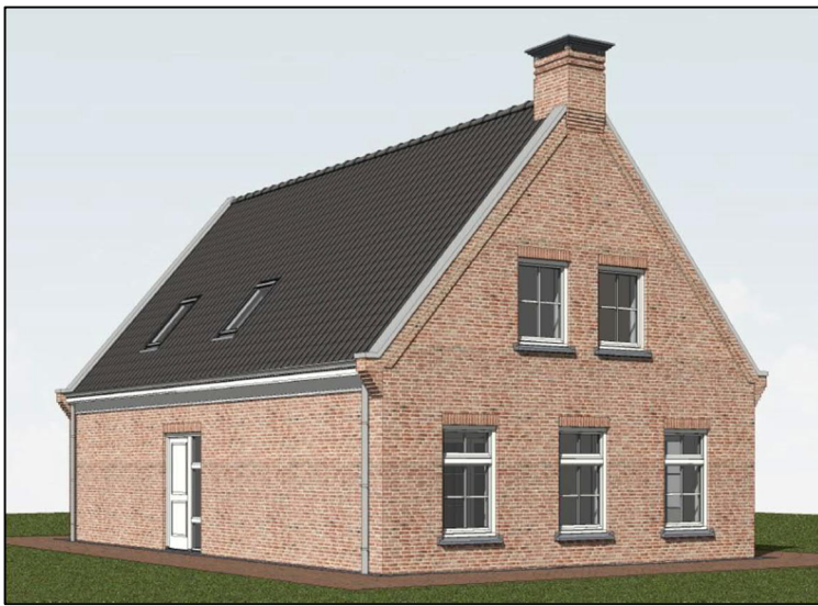
Afbeelding 3 Buitenaanzicht nieuwe woning
