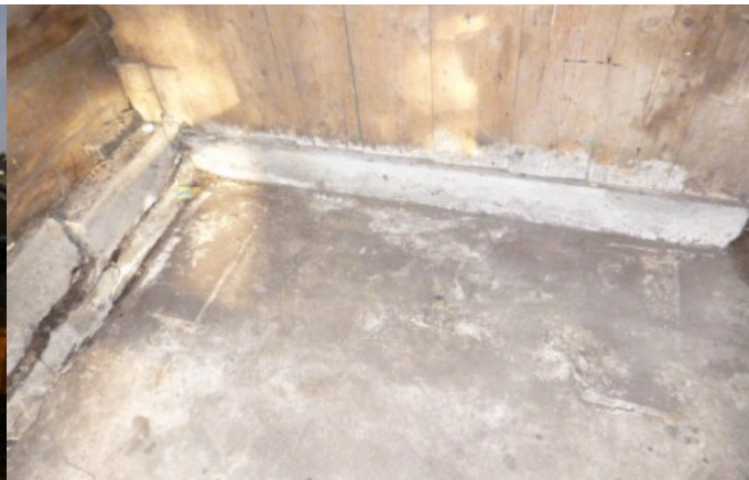
toelichting foto: locatie van gesaneerde materialen in berging
