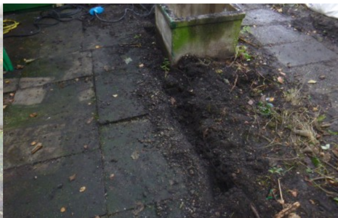
toelichting foto: locatie van gesaneerde AC vlakke plaat als beschoeiing
