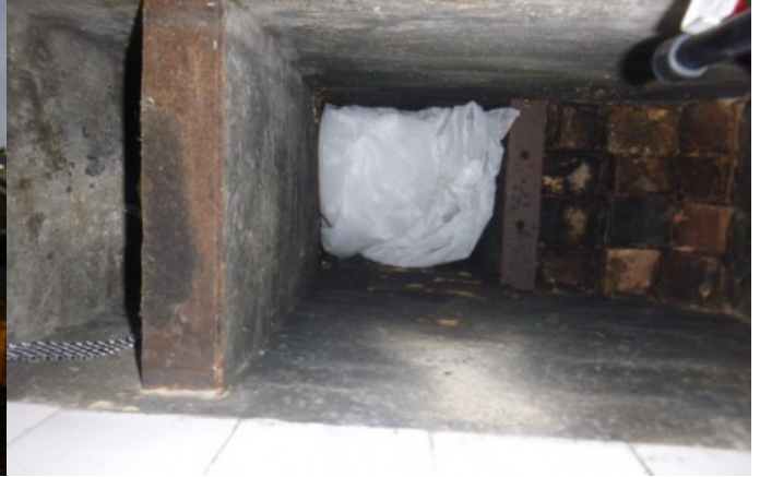
toelichting foto: locatie van gesaneerde AC vlakke plaat
