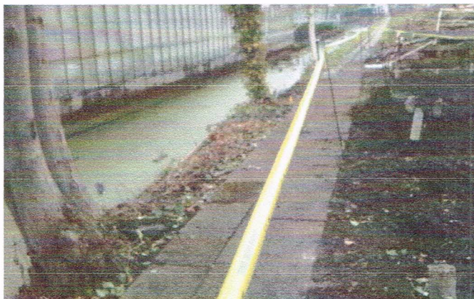
toelichting foto: afzetlint niet rondom op 5 meter
