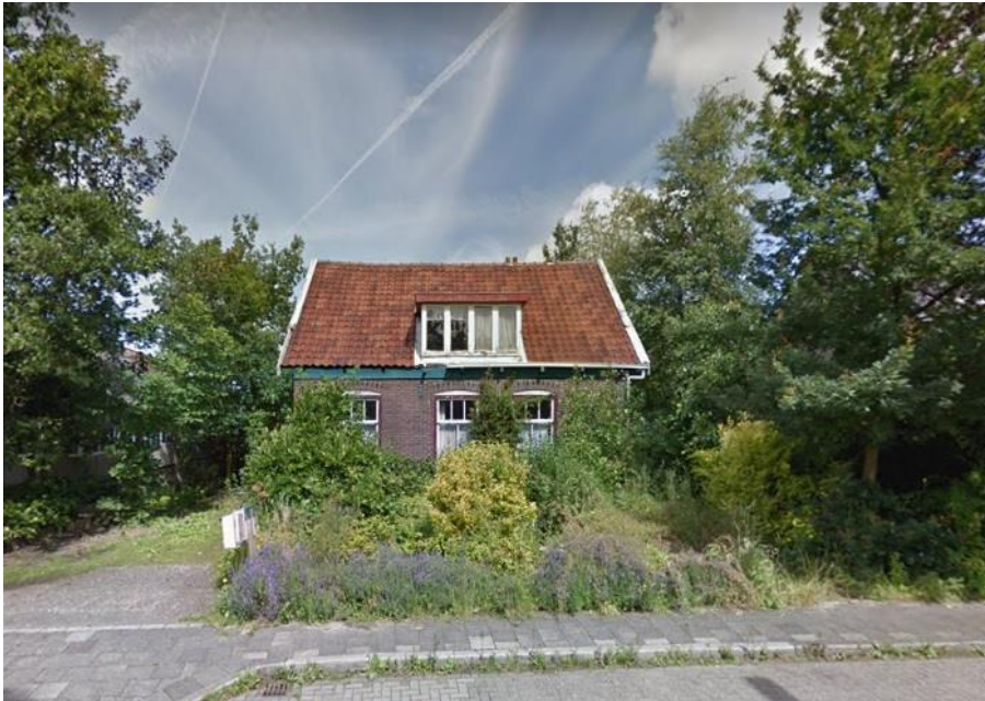
Figuur 4 (Gesaneerde) bedrijfswoning aan de Oosteinderweg 49
