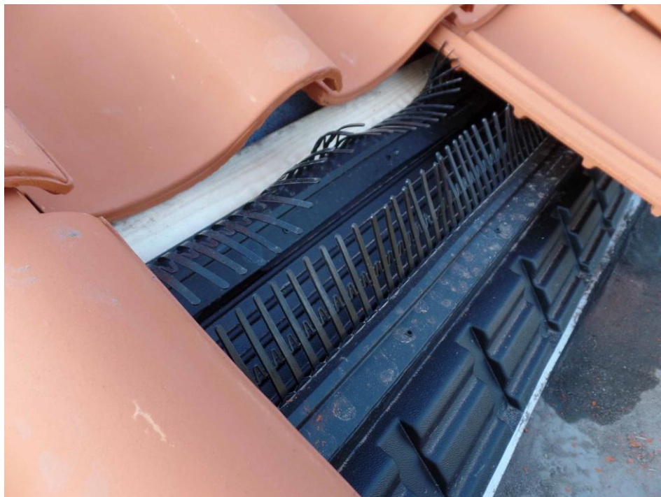
Figuur 9: Een vogelvide wordt onder de eerste rij dakpannen geplaatst.
