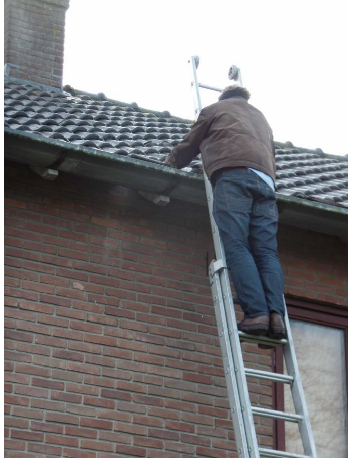
Figuur 6: Inspectie onder de dakpannen
