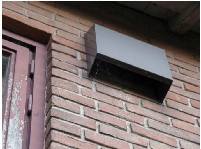
Figuur 8: Een isolatie-suskast op de gevel van de woning
