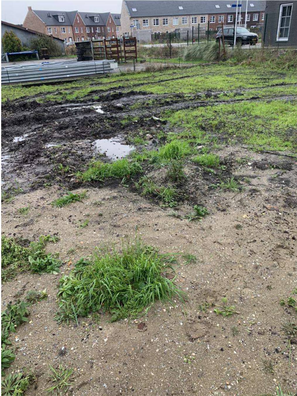
Opengereden kleigrond en deels is er zand opgebracht
