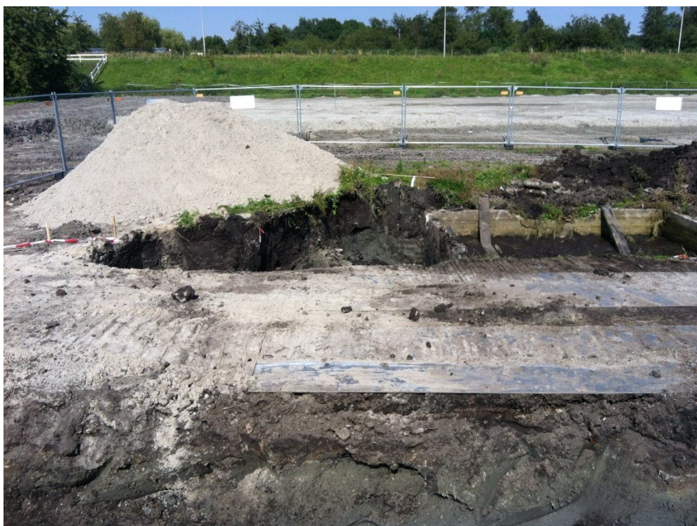
Foto 4, 15 augustus 2012: overzicht andere ontgravingsput tot 1,0 m -mv
