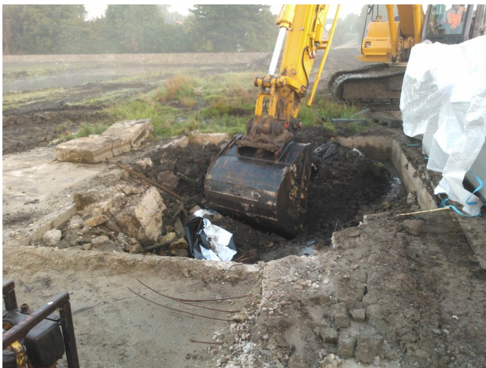
Foto 8 15 augustus 2012: ontgraven funderingsbak.
