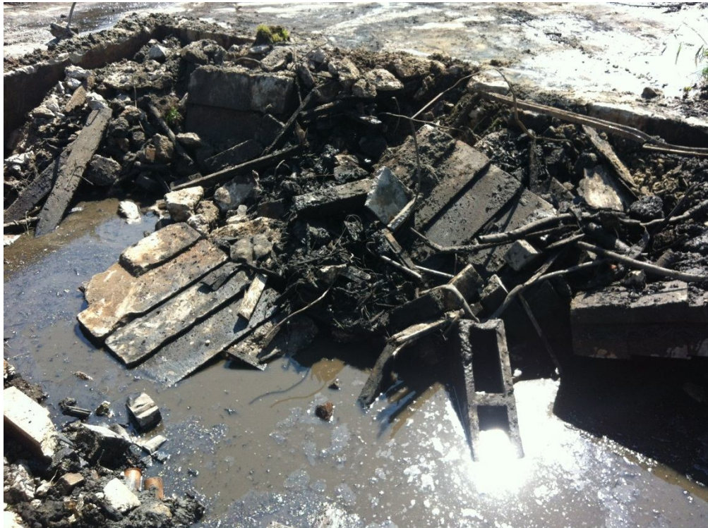
Foto 11, 15 augustus 2012: overzicht puinmateriaal nog aanwezig in de funderingsbak.
