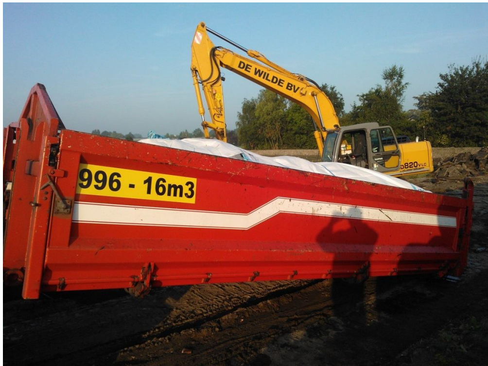
Foto 15, dubbel verpakt in container wordt het asbesthoudende puin afgevoerd.
