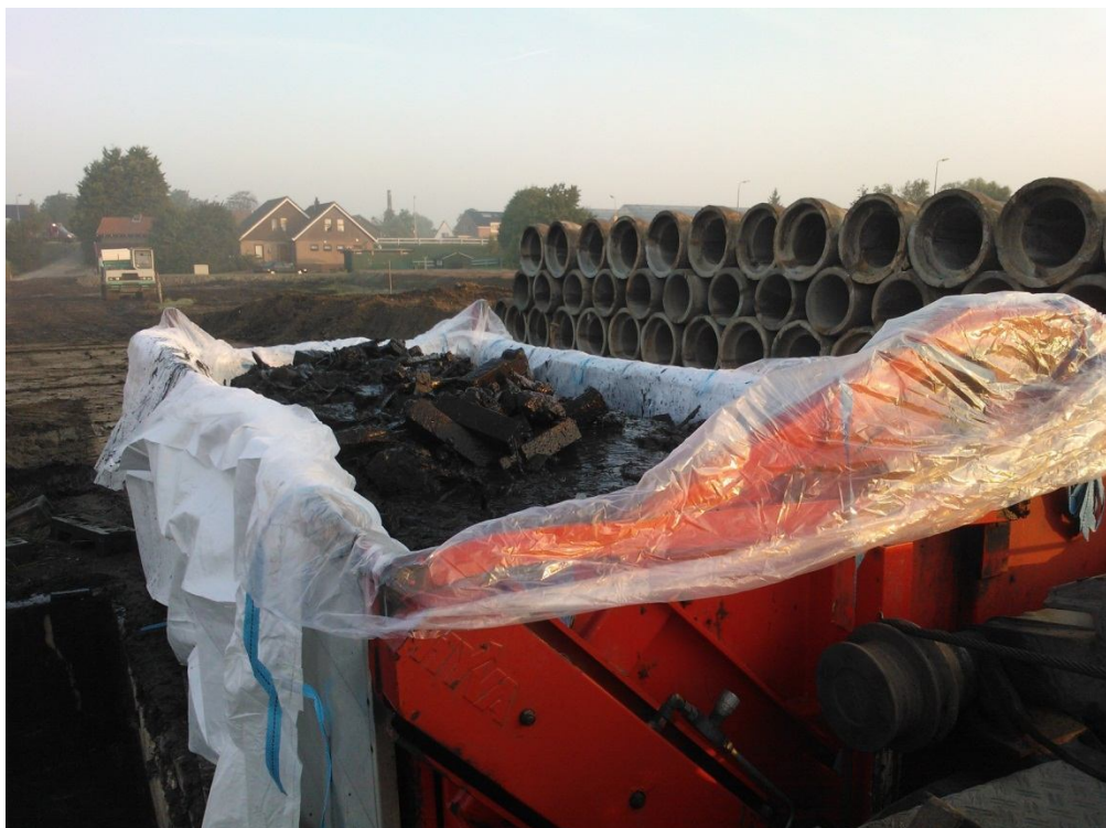
Foto 14, asbesthoudende partij puin wordt dubbel verpakt in een container geladen.
