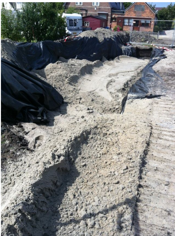
Foto 6, 16 augustus 2012: aanvullen ontgravingsputten over het folie
