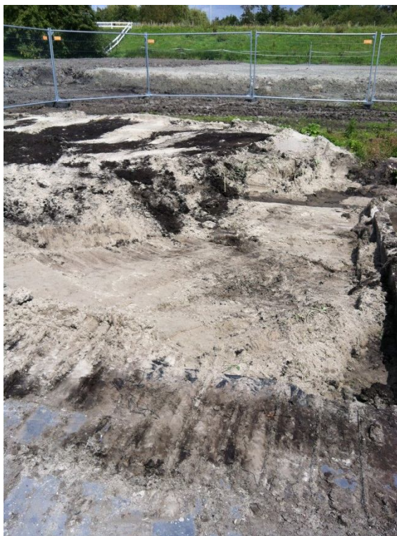
Foto 7, 16 augustus 2012: overzicht aanvullen andere ontgravingsput (naast de betonput).
