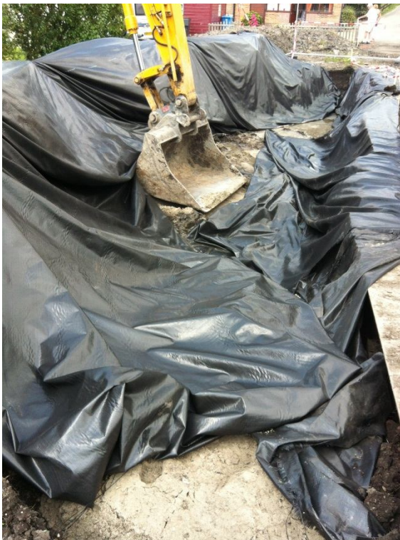
Foto 5, 16 augustus 2012: aanbrengen folie bij putwanden
