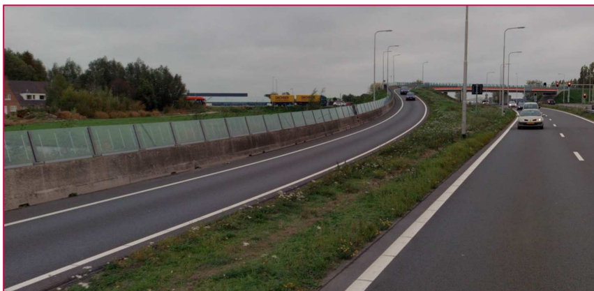
Figuur 3.2: Impressie van de aanwezige geluidsafscherming
