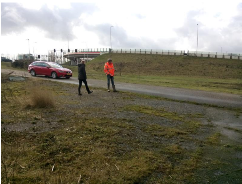
Deelgebied 1: Asfalt met asbesthoudend puinverharding eronder
