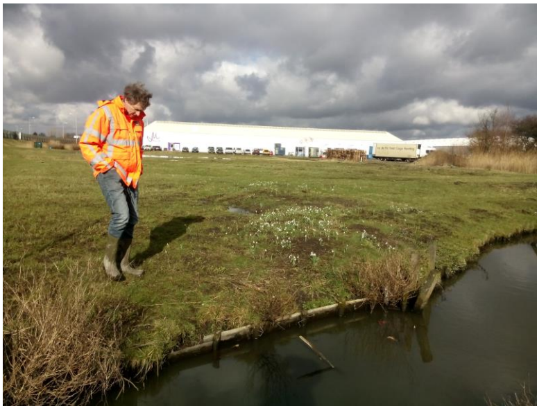
Deelgebied 2- Waterbodem en mogelijk asbestbeschoeiing
