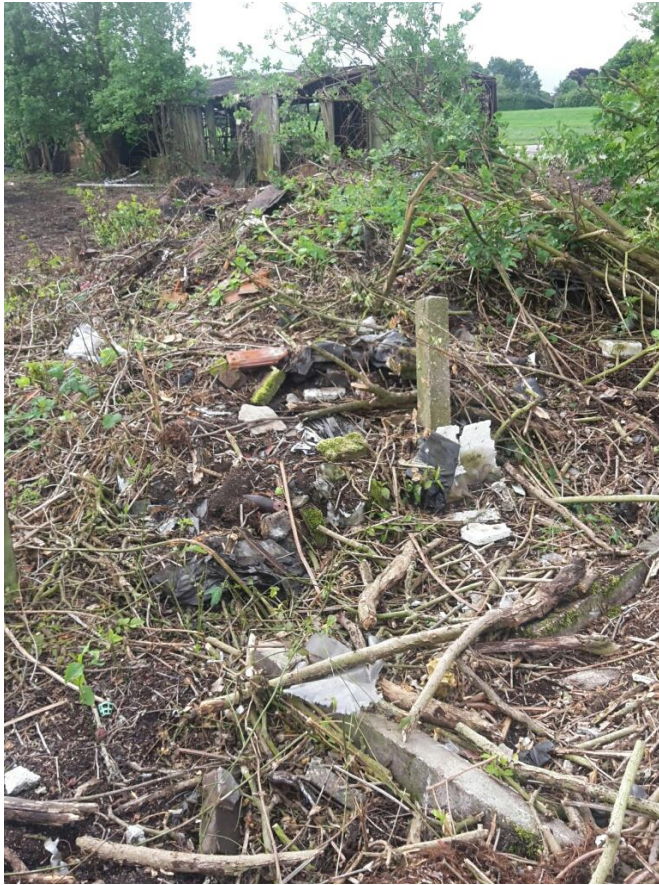
Foto 4 Puin bij bouwvallige opstallen
