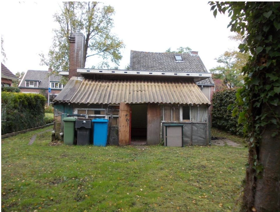
Foto 4: Zicht vanuit zuidwestzijde op onderzoekslocatie.
